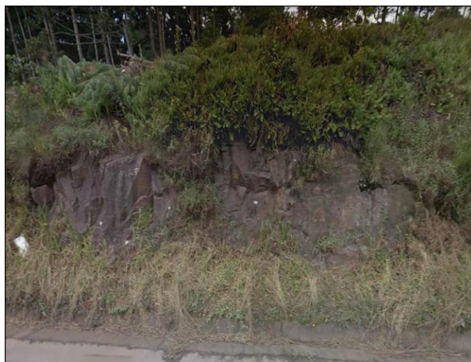
Figura 37 – Afloramento de rochas da Formação Rio Turvo, composto essencialmente por siltitos junto a SC-418 km 53.
